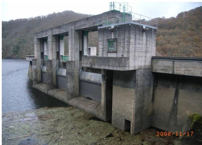
**Figure 13 : Vannes wagon du barrage de Marèges (France)**
