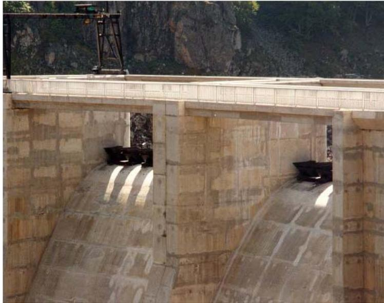
**Figure 12 : Déversoir à hausses fusibles du barrage de Puylaurent (France)**
